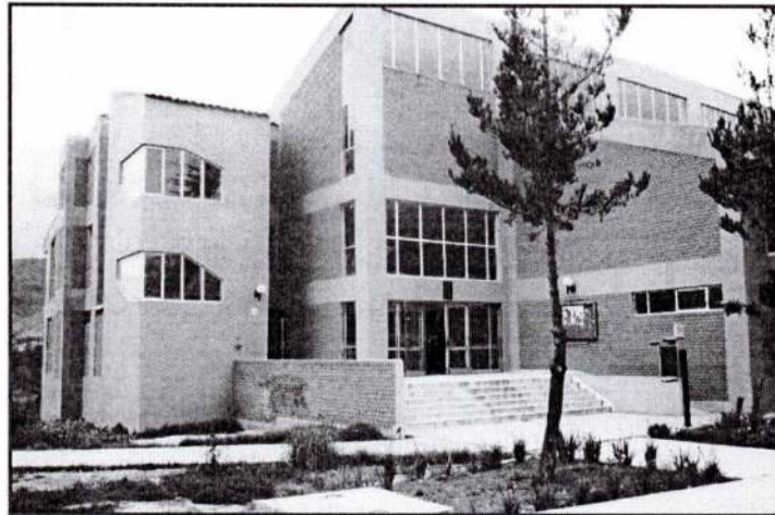
Figura 8: Biblioteca central de la UNSCH.
